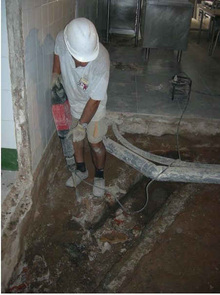
Figura 7. Procès de desmuntatge de la claveguera
