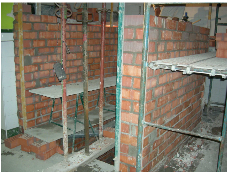
Figura 12. Construcció del calaix de l'ascensor un cop finalitzats els treballs d'excavació i documentació arqueològica
