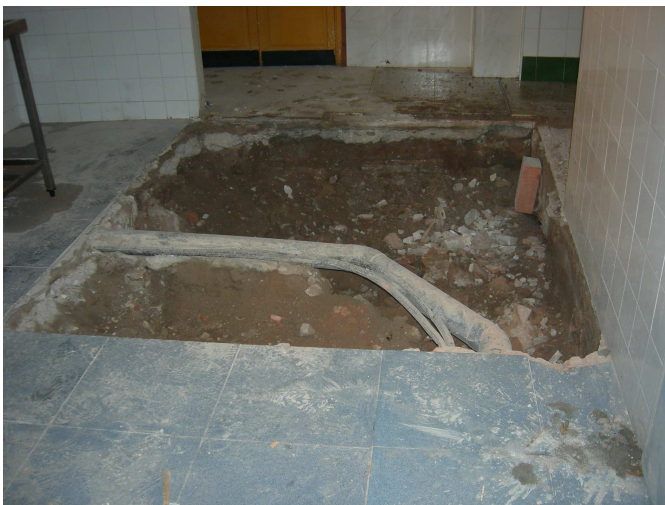
Figura 3. Primers treballs d'excavació per mitjans mecànics (unitats estratigràfiques 1000, 1001, 1002 i 1003)
